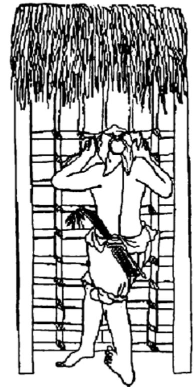
FIG. 32.- CONSTRUCTION D'UN MUR EN TERRE
